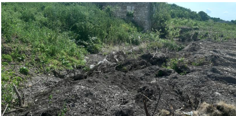
Az árok 062 hrsz.-ú ingatlan melletti szakasza (saját fotó)
