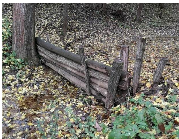
Az északról lefutó vízfolyásoknál alkalmazható, a kisvizeket még átengedő rönkgát Püspökszilágyon (forrás: https://life-climcoop.hu/ )
